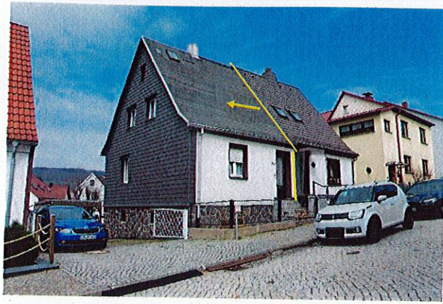
Süd- West- Ansicht des Wohnhauses vom Straßenraum
