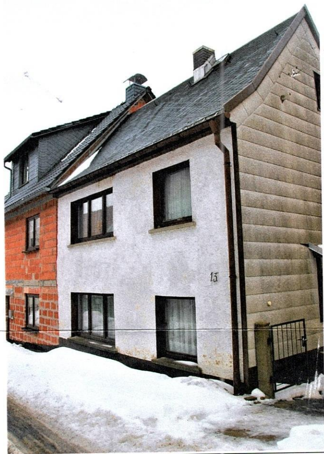
10 K 38/20 Amtsgericht Meiningen Nordwestansicht
